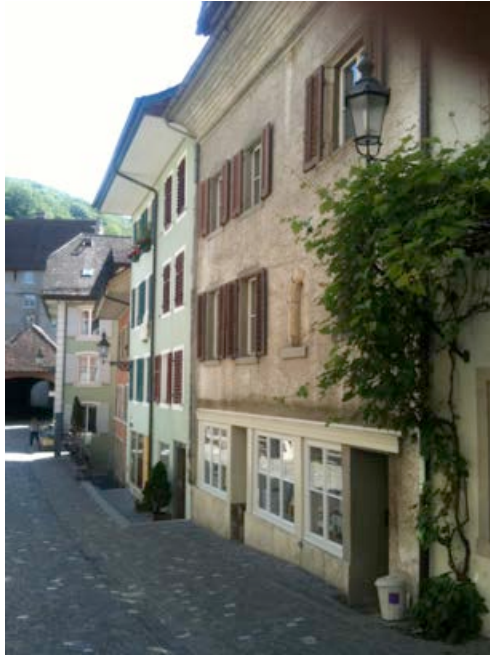
Ansicht von Seite Halde Nr. 7 in Richtung Brücke
