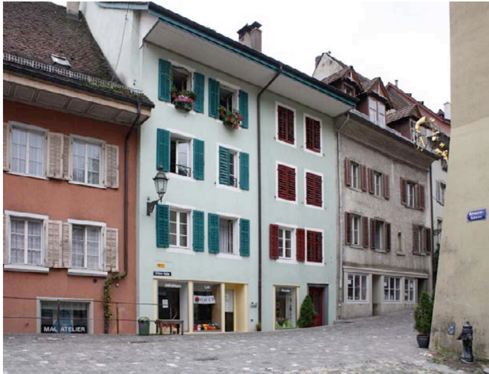
Halde Nr. 5 a (mit grünen Fensterläden) und 5b (mit dunkelroten Fensterläden), rechts daneben Nr. 7
